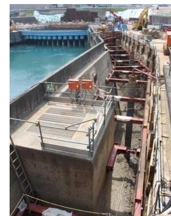
4号取水槽周りの地盤改良工事
