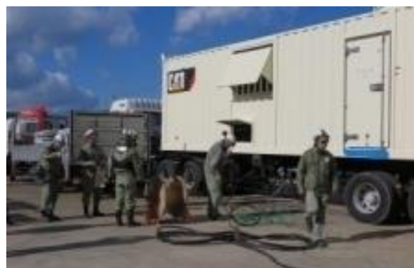
電源車操作訓練
