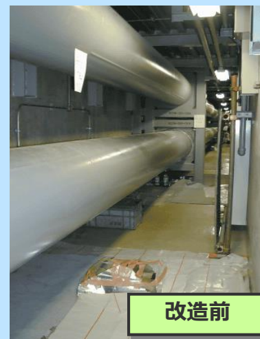
配管・電路類サポート改造工事（合計約5,000箇所）
