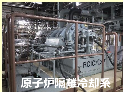
原子炉注水設備(タービン駆動)
