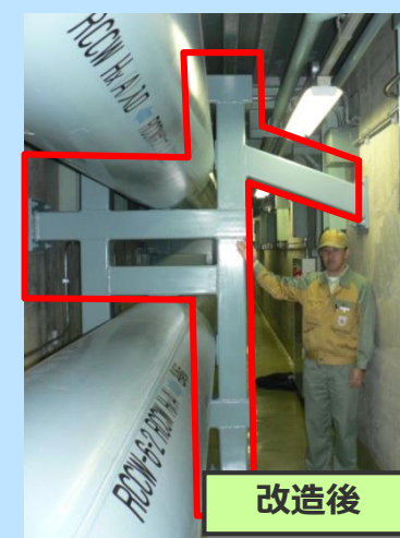
配管・電路類サポート改造工事（合計約5,000箇所）
