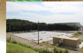
Ⓜ緊急時淡水貯槽
