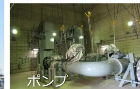
ⓐ緊急時海水取水設備
