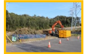
防火帯設置工事の様子
