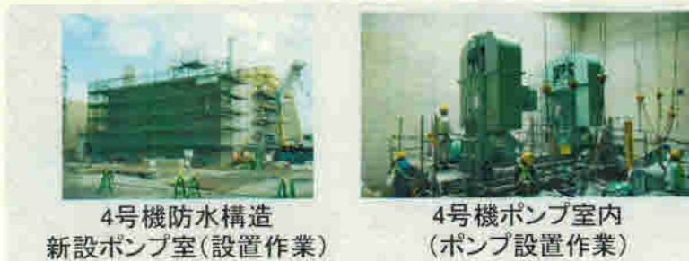
【緊急時海水取水設備(EWS)】
