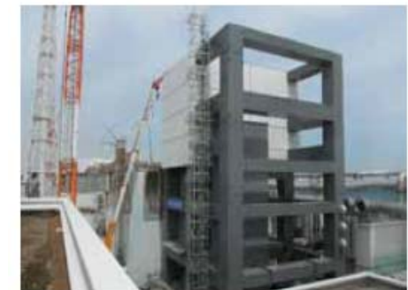
鉄骨建方実施状況 (4/23 撮影)
