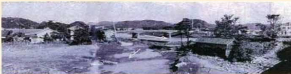
昭和57年9月 朝比奈川被害状況 (藤枝市横内地区)
