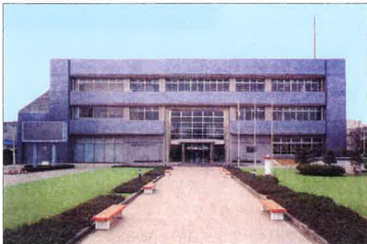
耐震化された建物
