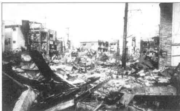
阪神・淡路大震災 神戸市内建物崩壊
