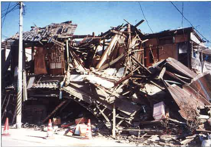
被災した建築物
