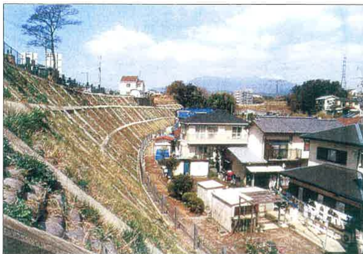
山崩れ等防止工事
