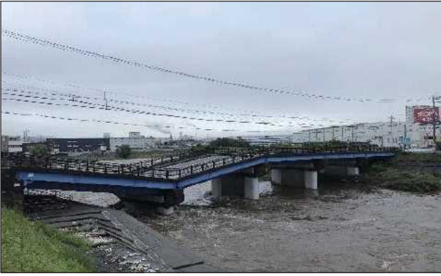
令和3年7月 沼津市黄瀬川大橋
