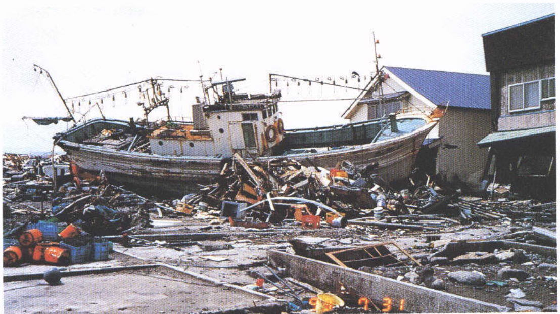
津波による被害例 (1993年 北海道南西沖地震)
