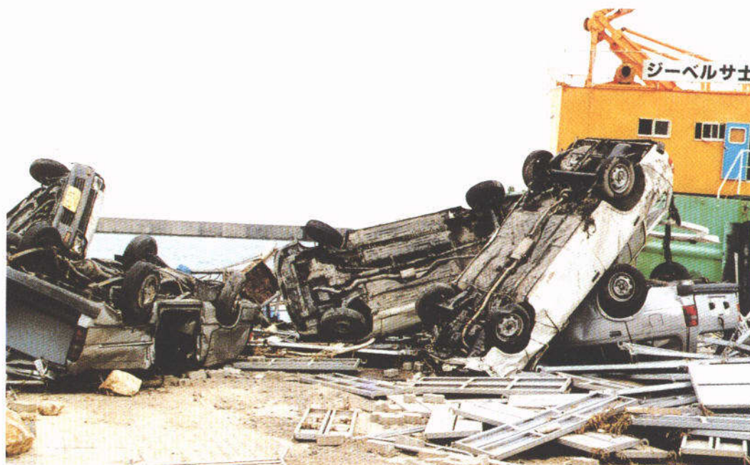
大津波による被害例 (1993年 北海道南西沖地震)
