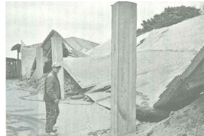
霧島山の噴火で積もった降灰により全壊した建屋 (2011/2/5 日本経済新聞朝刊)
