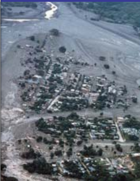
○土石流および融 雪型火山泥流
