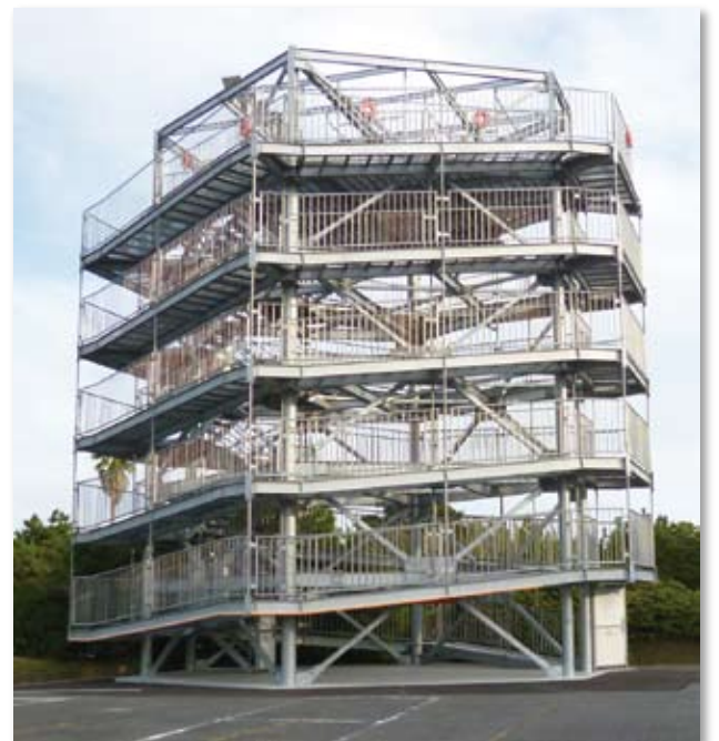
津波避難タワー
