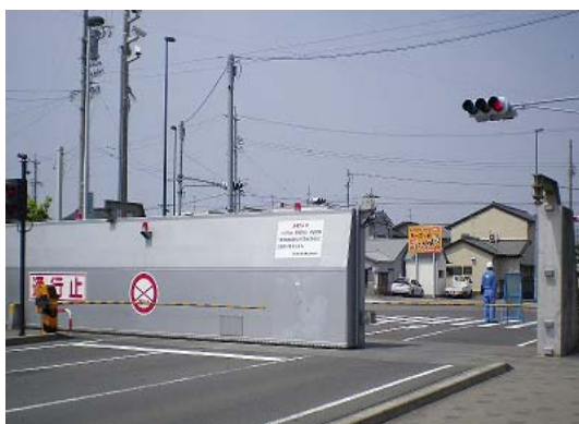
[ 陸閘閉鎖点検 ]
