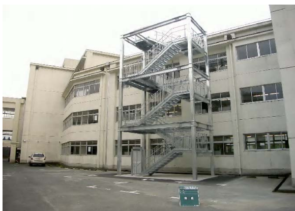
浜松湖南高校 校舎屋上への避難階段
