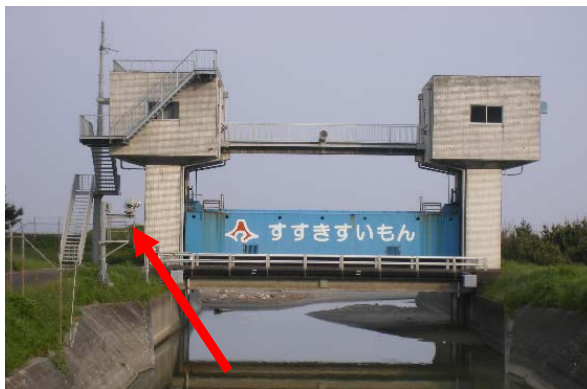
須々木水門屋上への避難階段
