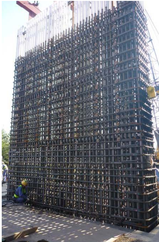
地中壁の鉄筋かご建て込み作業
