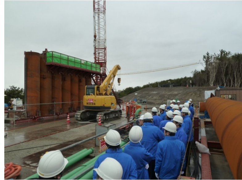
防波壁(西側端部)
