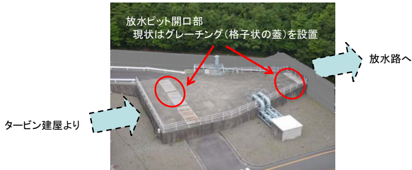
放水ピット開口部 の具体例(4号機)
