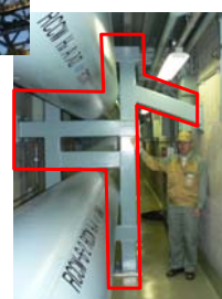
(写真右) 配管の耐震上の余裕を向上させるため、既設サポートの改造や新サポートを追加設置。 (3～5号機合計6,000箇所)
