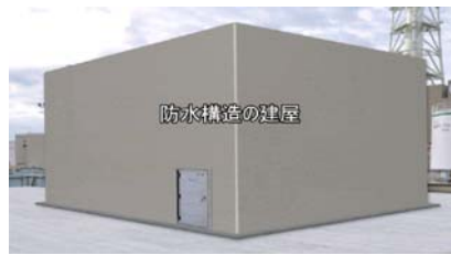
EWS設置・防水構造建屋
