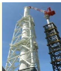
(写真右) 配管の耐震上の余裕を向上させるため、既設サポートの改造や新サポートを追加設置。 (3～5号機合計6,000箇所)
