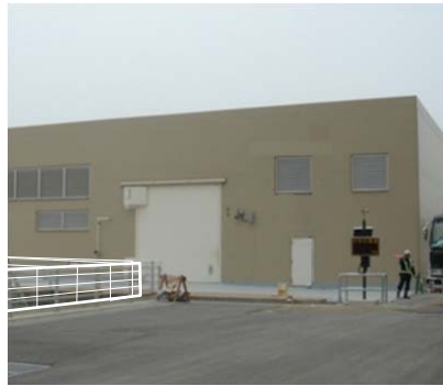
海水熱交換器建屋 改造前
