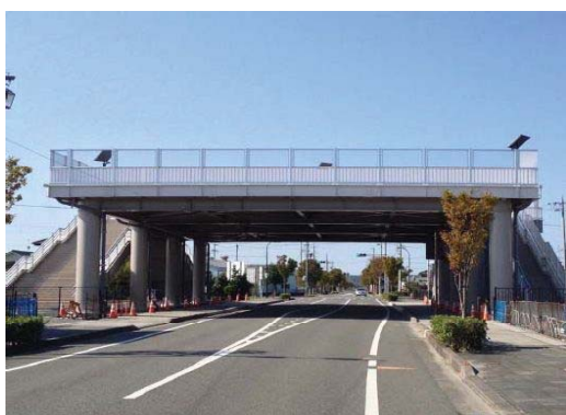
〔吉田町〕歩道橋型の避難タワー
