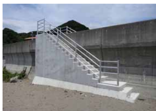
妻良漁港内から内陸側への避難階段
