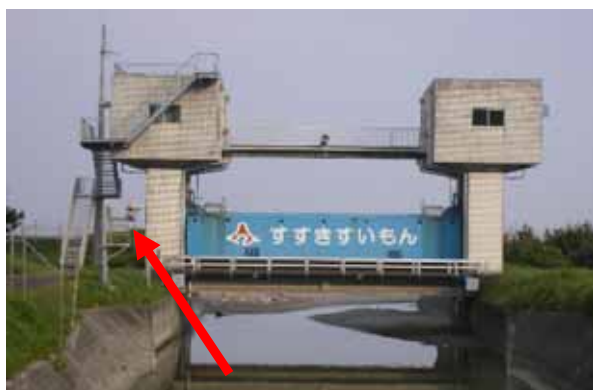
須々木水門屋上への避難階段
