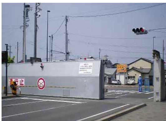
[ 陸閘閉鎖点検 ]
