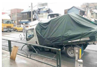
道路の陥没状況①
