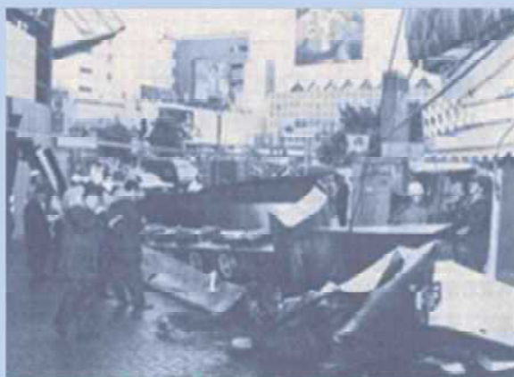
台風で落下した時の様子
