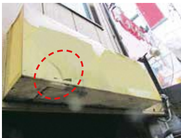
パネル板の破損
