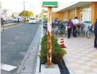
支柱の腐食
