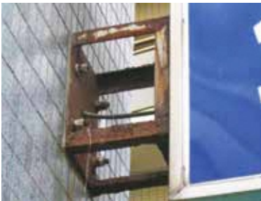
支柱の腐食
