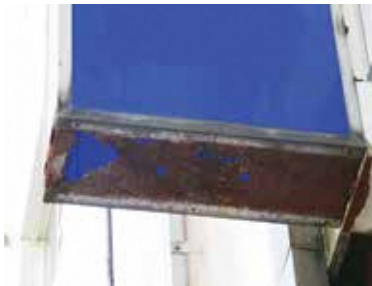
パネル板の破損
