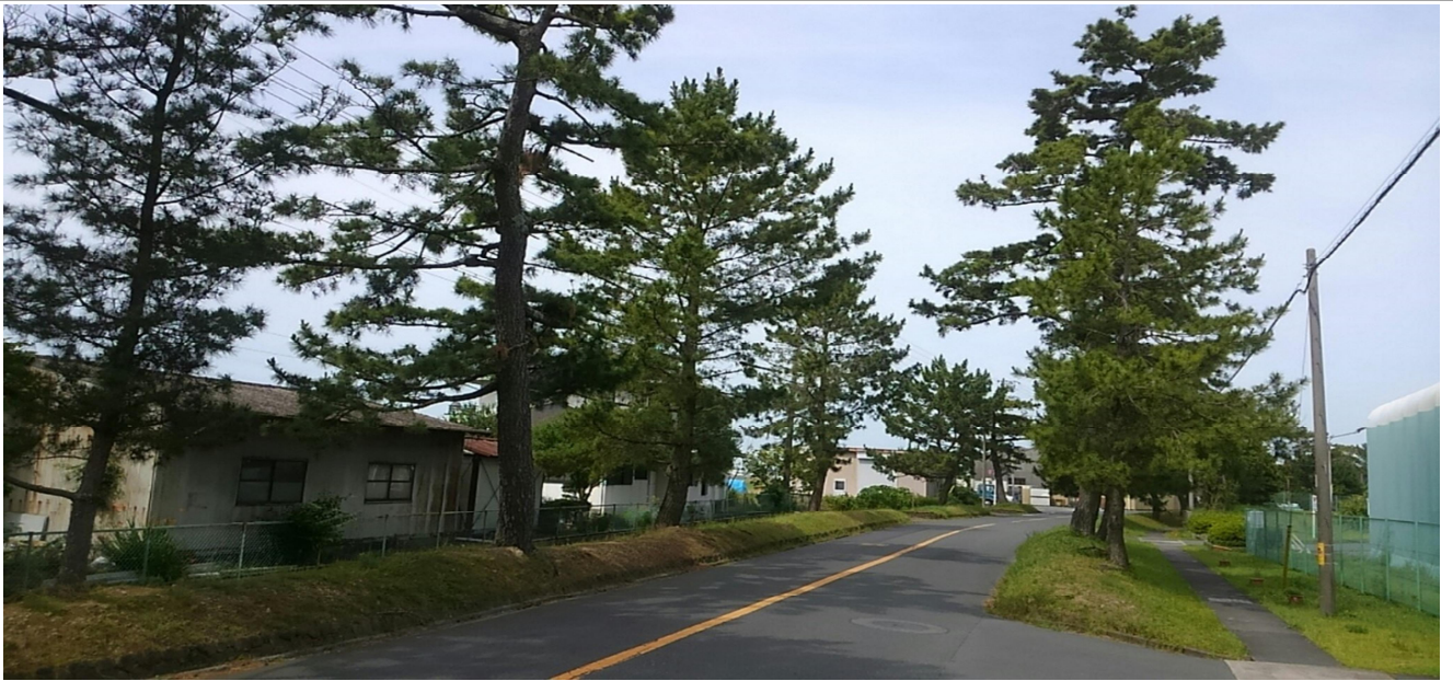
袋井市東地区旧東海道(県道)の保全された土塁に立ち並ぶ松並木 184 本
