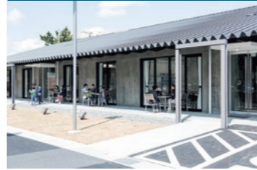
広い軒下によって生まれた憩いの場
