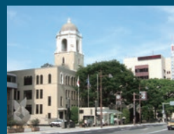
1989年 静岡市 静岡市庁舎本館
