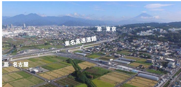
日本平久能山スマートIC 令和元年9月開通(静岡市)
