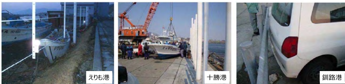
図 4-26 東北地方太平洋沖地震での津波漂流物対策の効果事例（北海道港湾）
