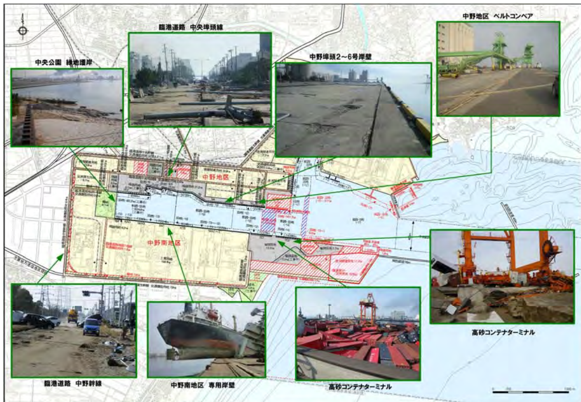
図 4-6 仙台塩釜港（仙台港区）被災状況
