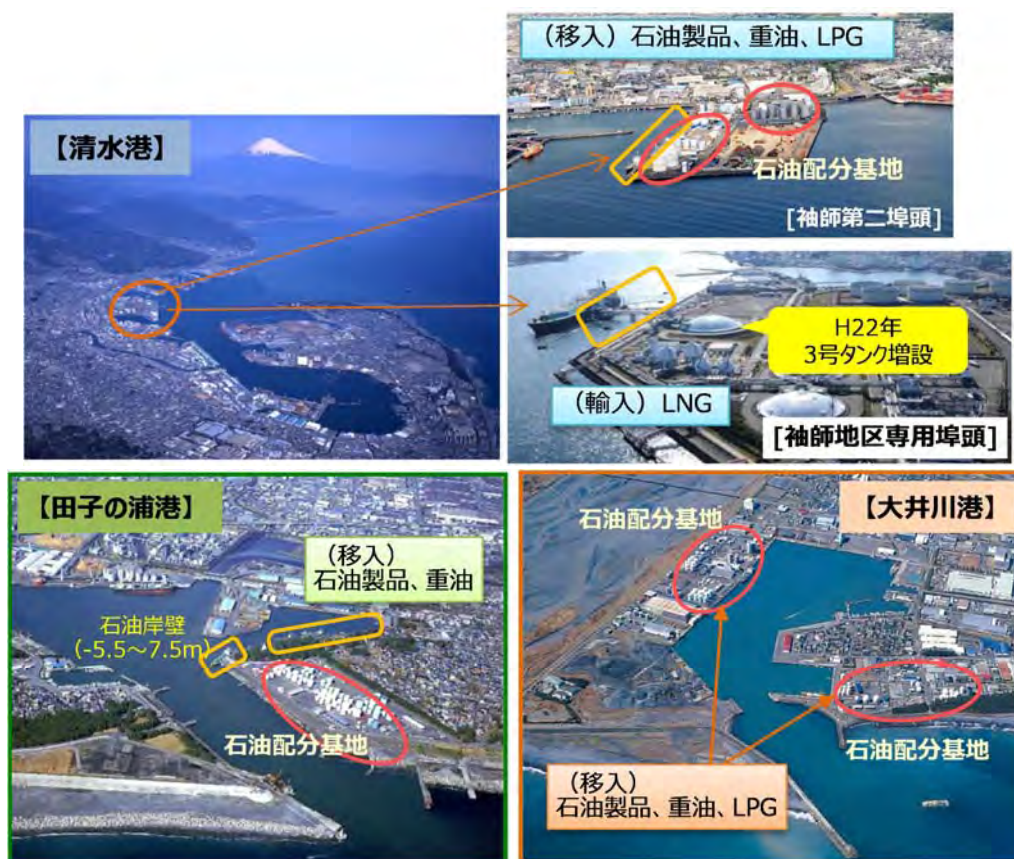
図 4-23 駿河湾港及び大井川港のエネルギー関連施設の状況
