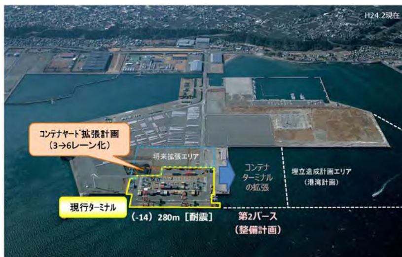
図 1-14 御前崎港コンテナターミナル整備状況
