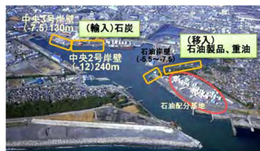
図 1-25 田子の浦港エネルギー関連施設の状況
