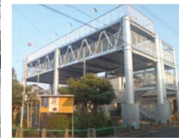
■避難タワーの整備
