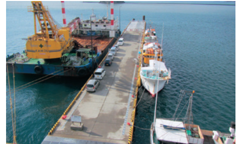
下田港物揚場整備状況
