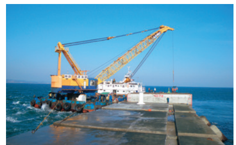
御前崎港防波堤整備状況 (写真提供:清水港湾事務所)
