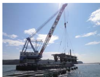
下田港整備状況
