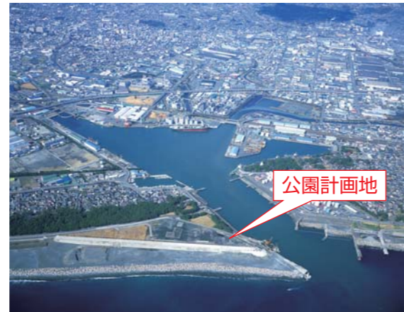
田子の浦港全景(平成18年頃)
