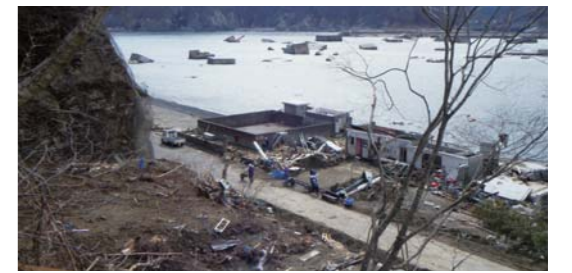
津波で破壊された防潮堤 (田老地区) (写真提供:静岡県支援先遣隊)
