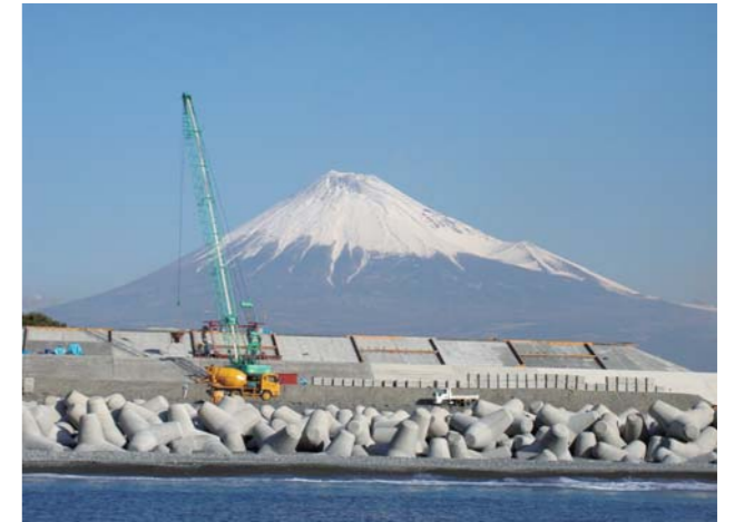
廃棄物埋立護岸築造の様子(平成12年頃)
