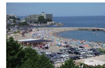
熱海港多賀地区の整備状況
