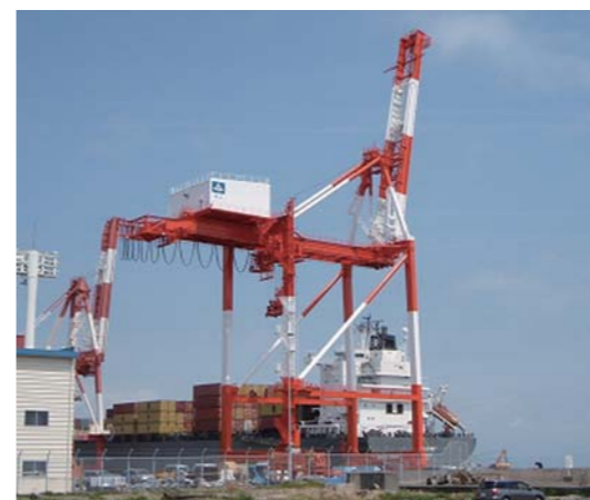
新コンテナクレーン完成
