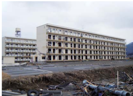
4階まで到達した津波 (沿岸部にある集合住宅) (陸前高田市) (写真提供:静岡県支援先遣隊)
