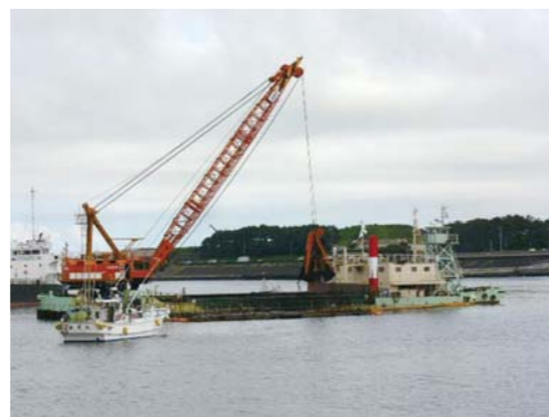
田子の浦港泊地浚渫状況
