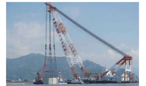
-15m岸壁整備状況 (写真提供:清水港湾事務所)
