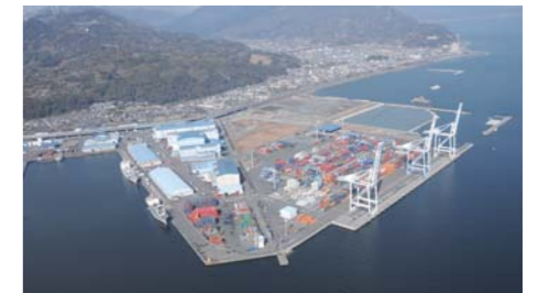
清水港新興津地区整備状況 (写真提供:清水港湾事務所)
