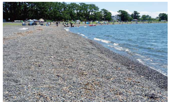
作業完了後の三保内浜
