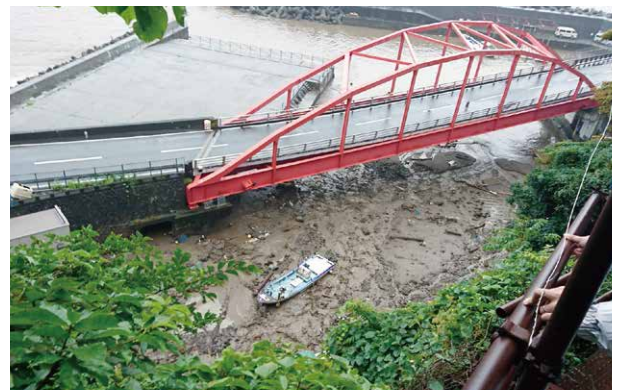
臨港道路の土砂・がれき堆積状況
