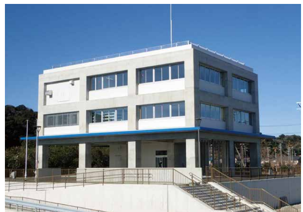
御前崎港管理事務所の新庁舎
