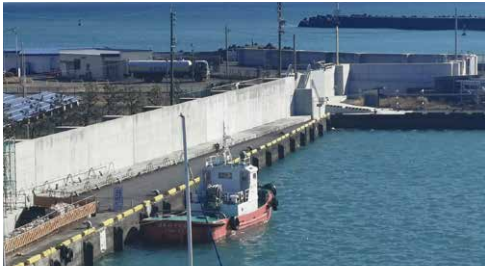
災害に備えるため、港内では「胸壁整備工事」を進めています。
