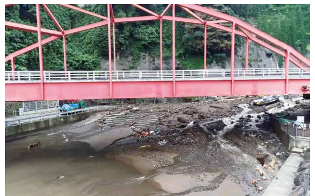
船揚場の土砂・がれき堆積状況
