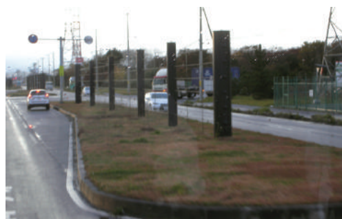
津波漂流物対策施設(仙台塩釜港仙台区)
