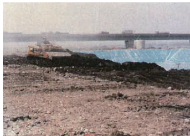
浚渫土砂の処理状況
