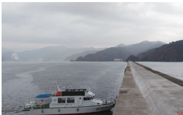
船上視察後、釜石港湾口防波堤に上陸
