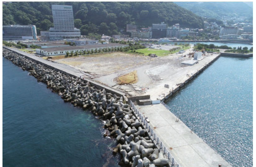
熱海港の被災状況
