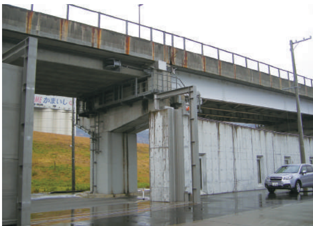
水門・陸閘自動閉鎖システム(釜石港)
