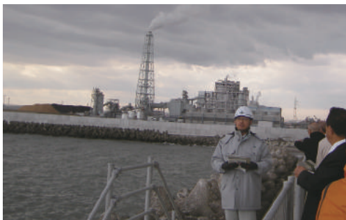
東浜防潮堤(仙台塩釜港石巻港区)にて概要説明
