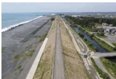
吉田町尻防潮堤(堤防盛土材)
