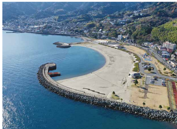
北工区の状況 (国土交通省清水港湾事務所撮影)
