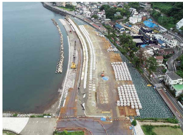
南工区の工事進捗状況
