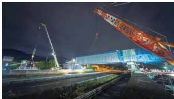
橋桁の架設工事中
