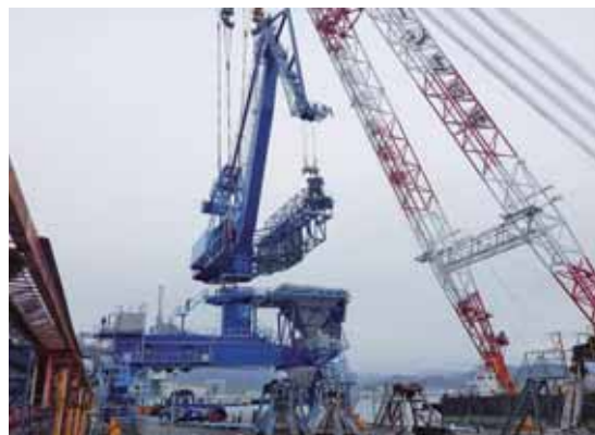
チップアンローダー据付け工事中
