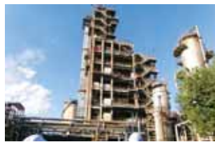
川崎プラスチックリサイクルプラント(KPR)
