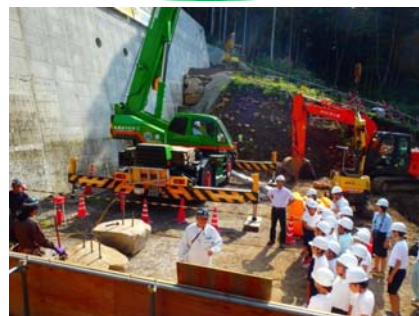
砂防事業の工事現場見学
