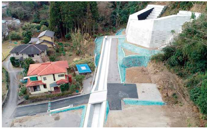
石脇沢砂防堰堤(伊東市八幡野)
