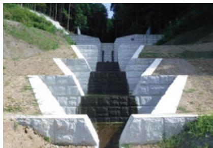
鹿群山砂防堰堤(令和2年3月完成)
