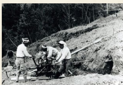
手動式ボーリング機による水抜きボーリング施工状況
