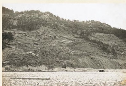
昭和8年の地すべりが発生した時の状況
