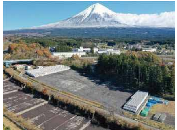
大型ブロックの備蓄状況
