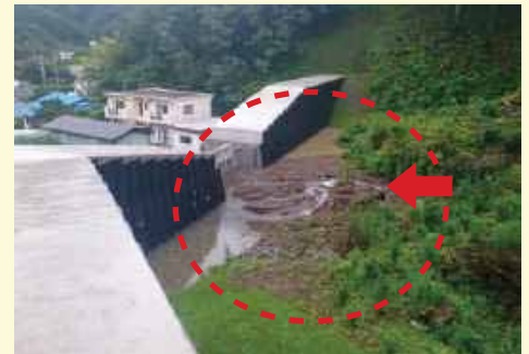
土石流(賀茂郡松崎町南郷) 砂防堰堤により流出土砂を捕捉
