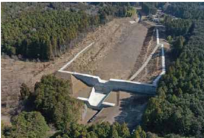
鞍骨沢遊砂池(R1完成)
