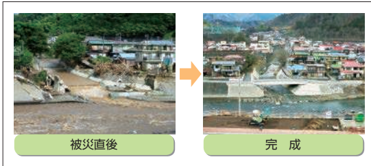
「野沢川に架かる下野沢橋復旧の様子」
