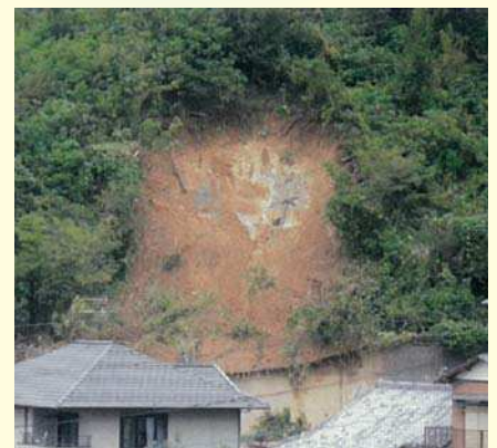
人家裏のがけ崩れの状況 (静岡市清水区大内)
