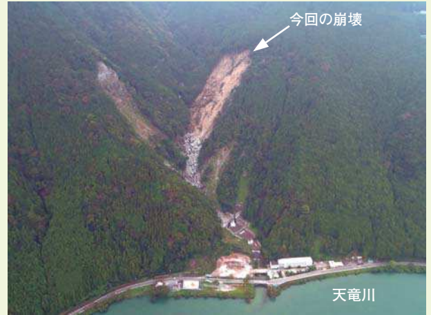
崩壊発生状況(H26.10.2 撮影)
