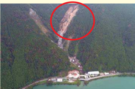
河内沢川流域の山腹崩壊状況 (浜松市天竜区龍山町瀬尻)
