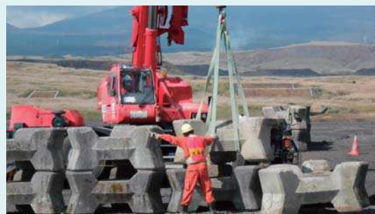
導流堤築堤作業実演の様子(御殿場市畑岡地区)
