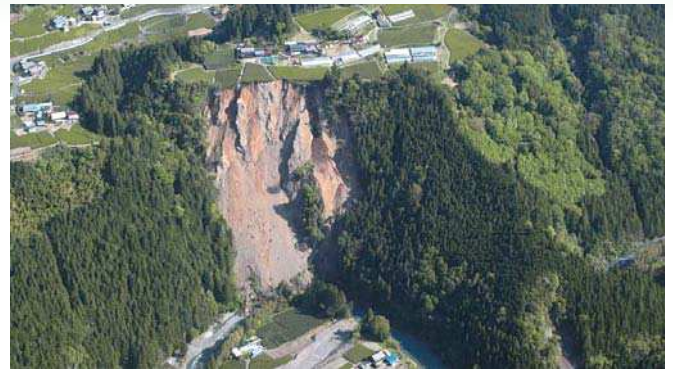
門島の地すべり災害発生状況(H25.4撮影)
