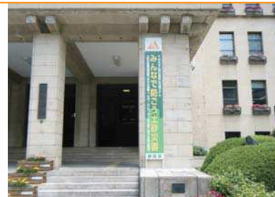
立看板の設置(静岡県庁正面玄関)
