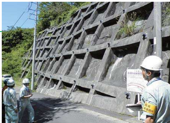
急傾斜地パトロールの写真
