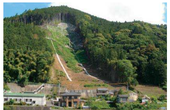
静岡市葵区桂山の急傾斜地施設整備状況 (H23災害)
