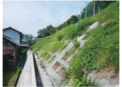
三輪平左工門急傾斜地
