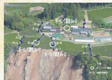
写真-3 地すべり挙動の監視体制 (崩壊後、H25.5.13の監視状況)
