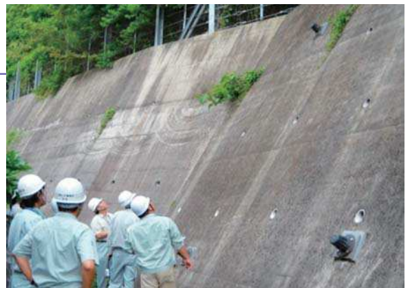
急傾斜地パトロールの様子
