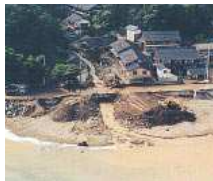
東立島地区土石流災害状況(平成10年8月4日)
