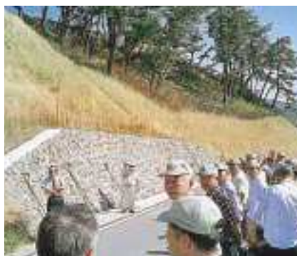
小六地すべり対策事業現場
