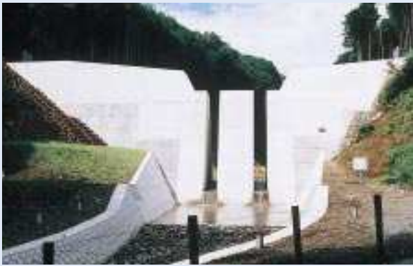
だいぼがわ 大場川右支川砂防堰堤
