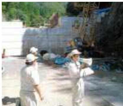
真野川通常砂防工事現場
