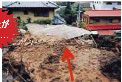
平成10年8月の土砂災害(函南町山田)
