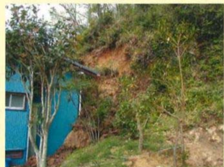
大久保がけ崩れ被災状況（賀茂村）被災日 H15.4.10
