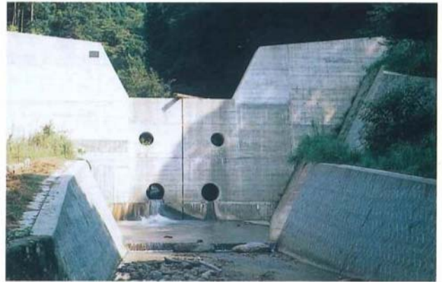
八木沢大川砂防堰堤
