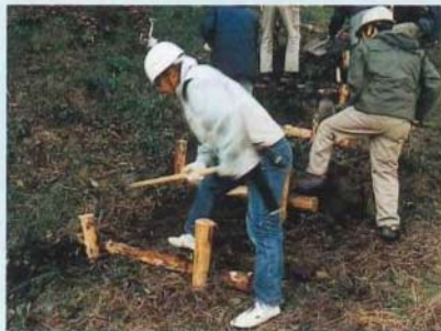
管理道の整備作業
