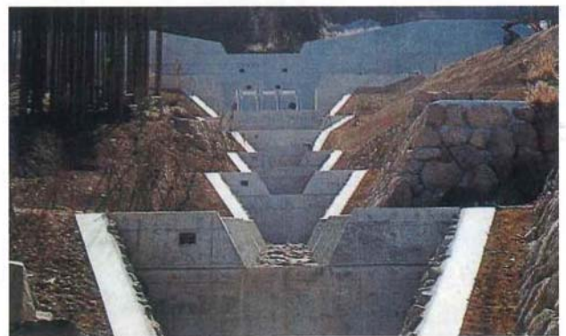
小谷之沢災害関連緊急砂防事業
