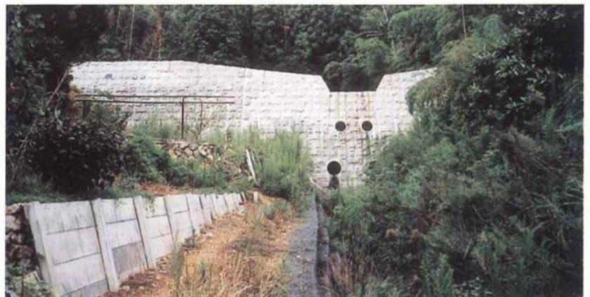
呉石沢砂防堰堤
