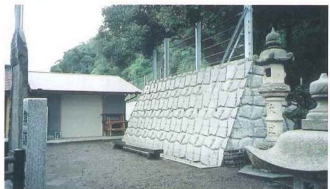
景観に配慮し整備の進む諏訪第3急傾斜地
