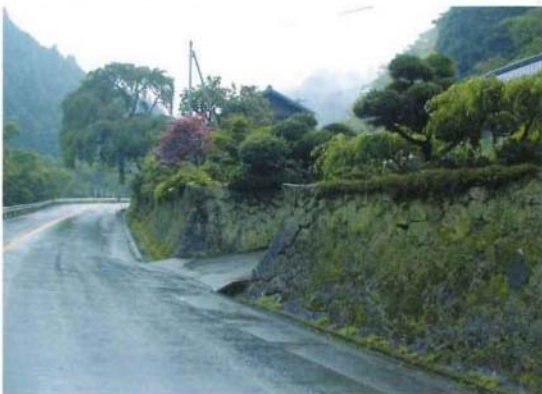
雨落とし石垣（塩出地区）
