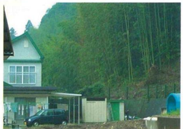
寺谷急傾斜地
