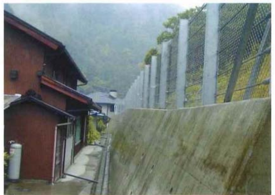
塩出急傾斜地
