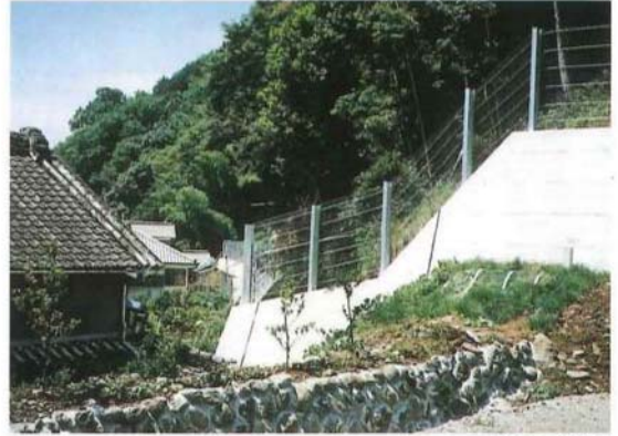
一色堀坂急傾斜地
