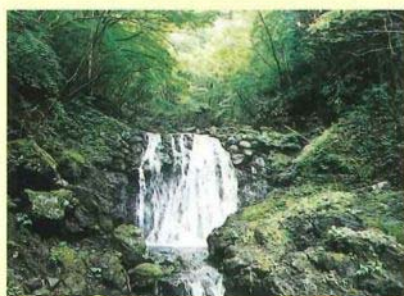
石積砂防堰堤
