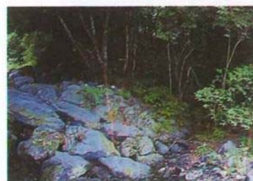
現在の仙俣川石積工
