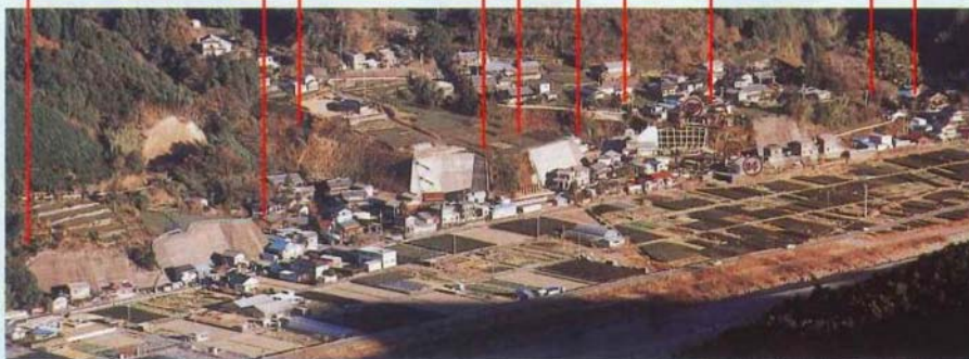
郷島地区急傾斜地対策（静岡市）
