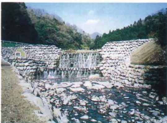
須津第一砂防堰堤
