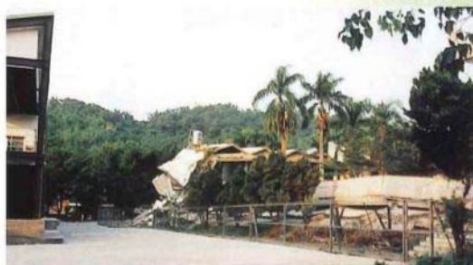
断層上で破壊された光復中学校
