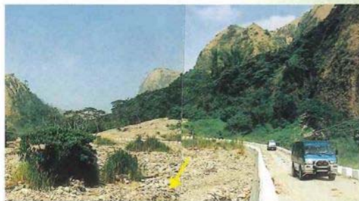
九十九峰付近の土石流災害現場
