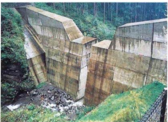
戸倉谷沢 砂防堰堤
